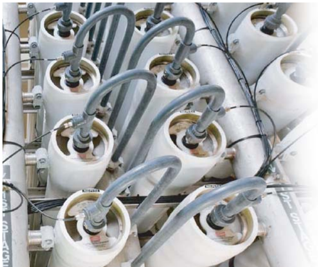
脱塩プラントで使われている市販の逆浸透膜ユニット
